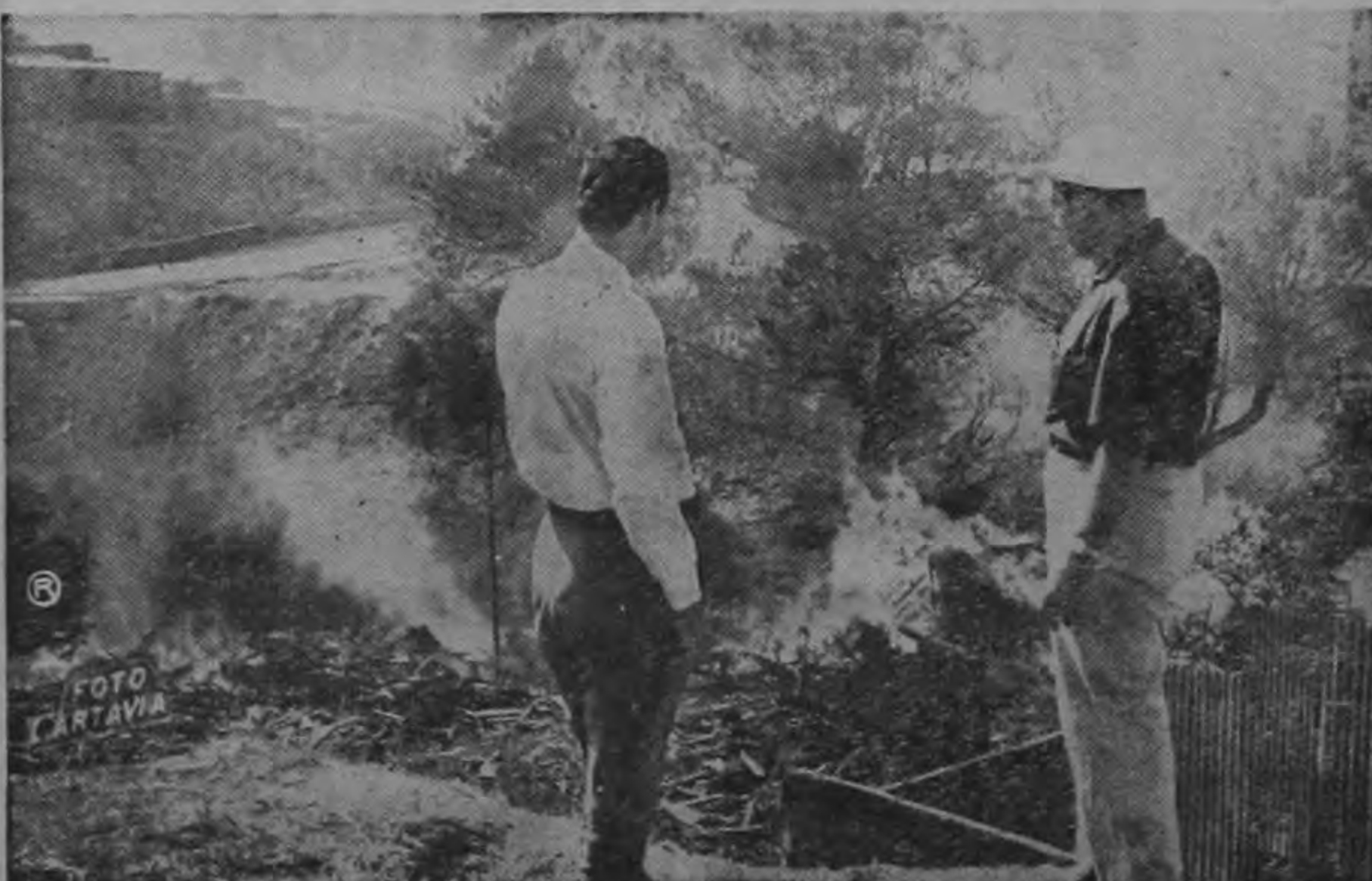
UNA VEZ que fueron demolidas las casas, se procedió a darles fuego contando con la cooperación del Cuerpo de Bomberos para evitar cualquier emergencia con otras propiedades. En la gráfica
